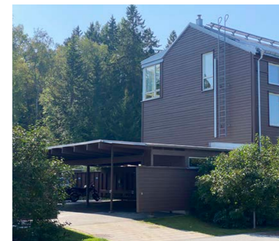
Innanför planket placeras även soprum. Planket löper runt hela parkeringsytan men undantag för en öppning på motsatt sida av inkörningen till parkeringen.
