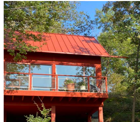
Volym & Detalj En villa som tydligt öppnar upp mot naturen med stora glaspartier och terrass.
